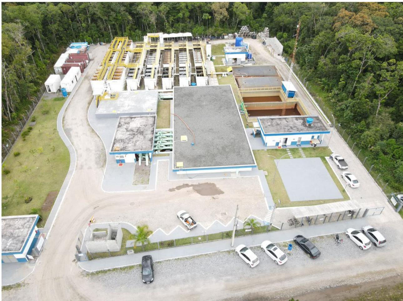
Figura 3 - Sistema de tratamento de lodo da ETA
